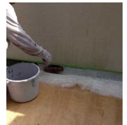
バルコニー防水工事
