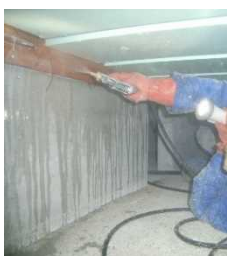
防蟻・防腐処理
