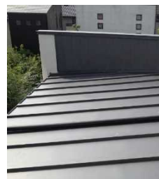
屋根改修工事
